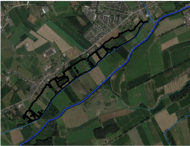
Figuur 13: Luchtfoto locatie 6 Wachtebeke
